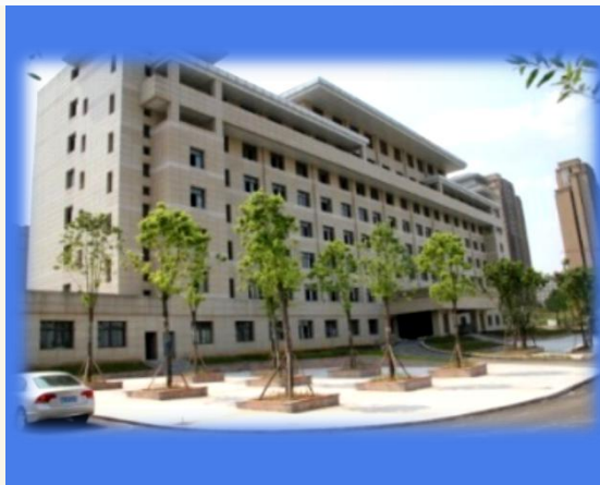
永川海关国检联检大楼
